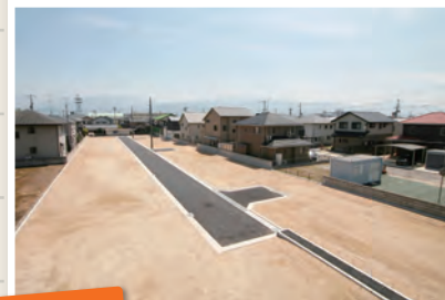
造成後 現地写真
