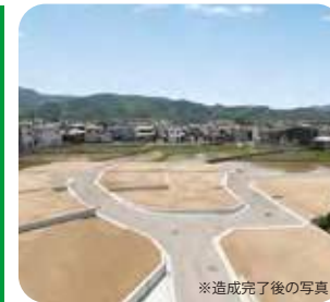
※造成完了後の写真
